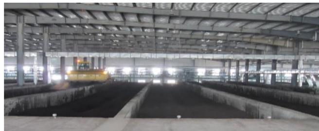
圖 13: 我們華東分部其中一個污水處理廠以生物浸出和脫水流程以處理污泥
